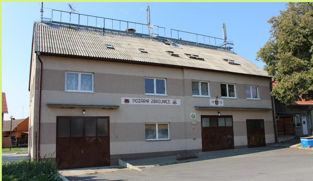
Obr. Budova Hasičské zbrojnice Troubky
