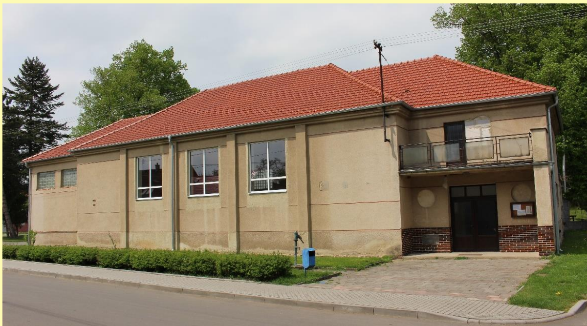
Obr. Rekonstruovaná střecha na budově Sokolovny v Obědkovicích
