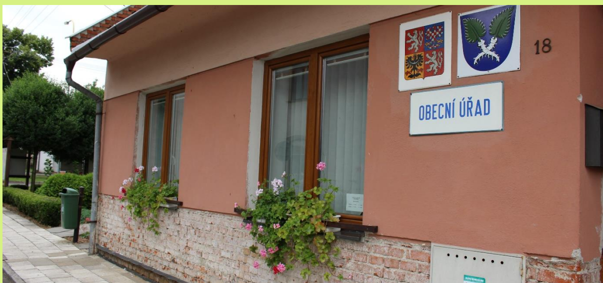
Obr. Pohled na nová plastová okna budovy obecního úřadu v Křenovicích
